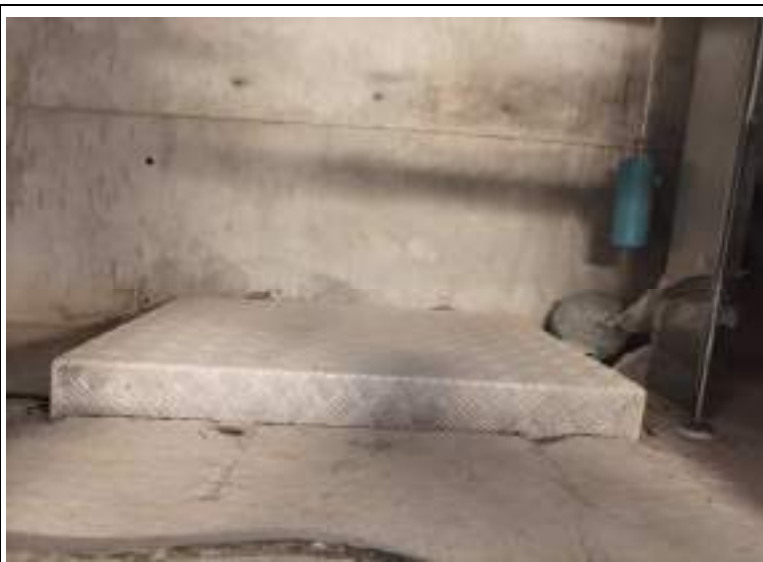
Trappe d'accès à la cuve Sud
