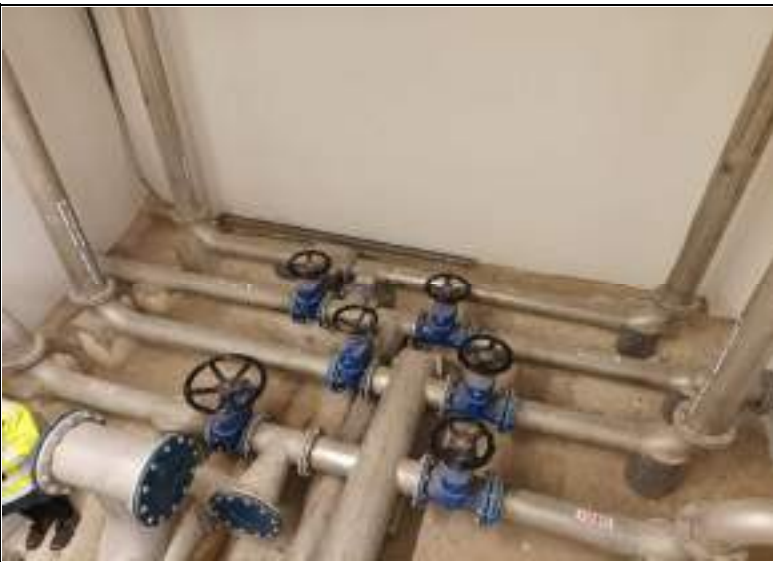
Chambre de vannes (N-1) - partie Est
