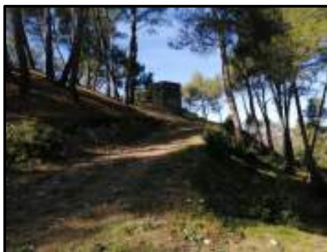
Figure 44 : Vue extérieure du réservoir de Mas-Blanc-des-Alpilles
