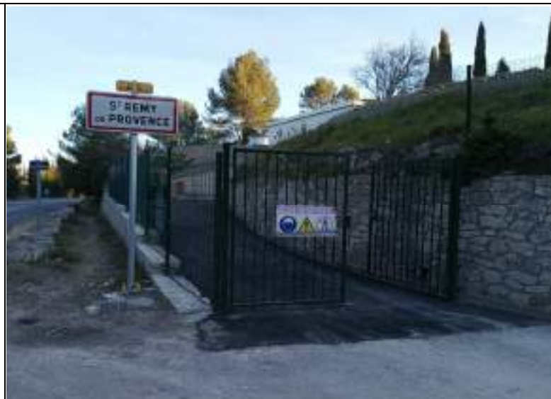
Vue extérieure du réservoir - portail
