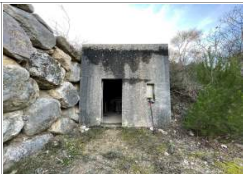
Vue extérieure du réservoir
