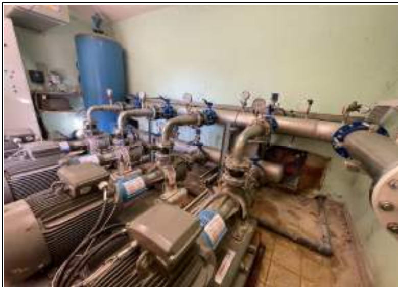
Chambre de vannes
