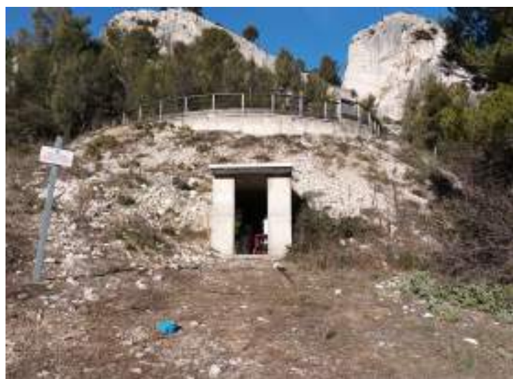
Vue extérieure du réservoir
