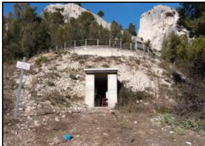
Figure 48 : Vue extérieure du réservoir des Alpilles
