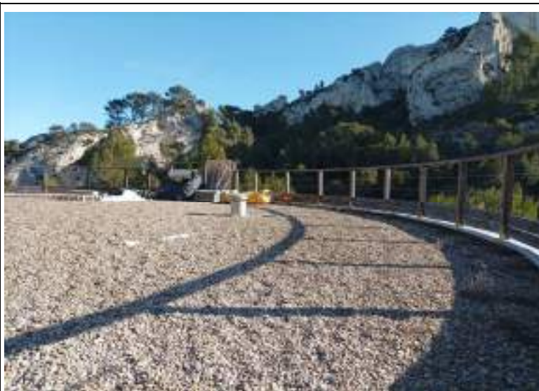
Toiture du réservoir avec accès à la cuve (en travaux - non accessible)
