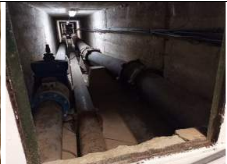
Passage des conduites sous la RD5
