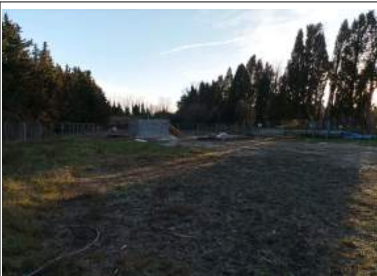
Nouveau forage en cours de construction
