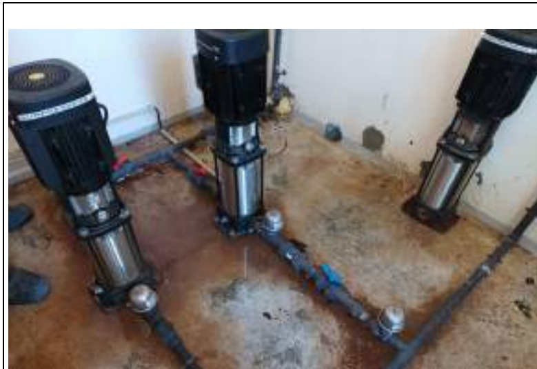
Local d'injection de chlore
