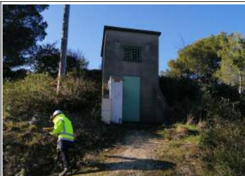
Vue extérieure du réservoir
