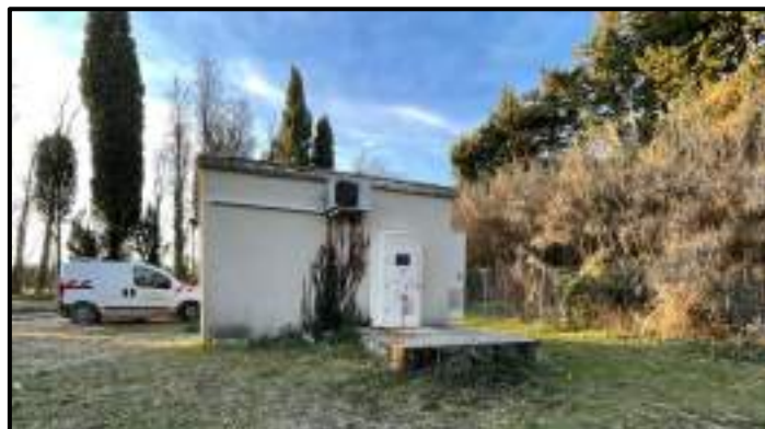
Figure 24 : Vue extérieure du forage des Méjades
