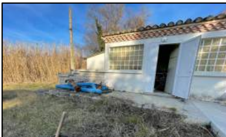
Figure 52 : Vue extérieure de la station de reprise d'Eygalières
