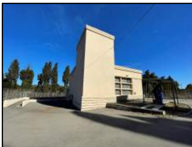
Figure 22 : Vue extérieure du puits des Paluds
