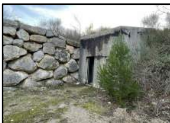
Figure 50 : Vue extérieure du Réservoir d'Eygalières
