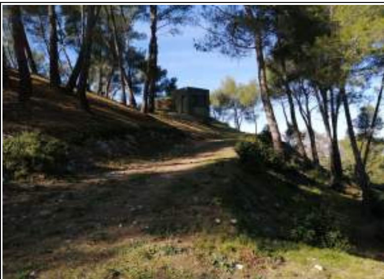
Vue extérieure du réservoir
