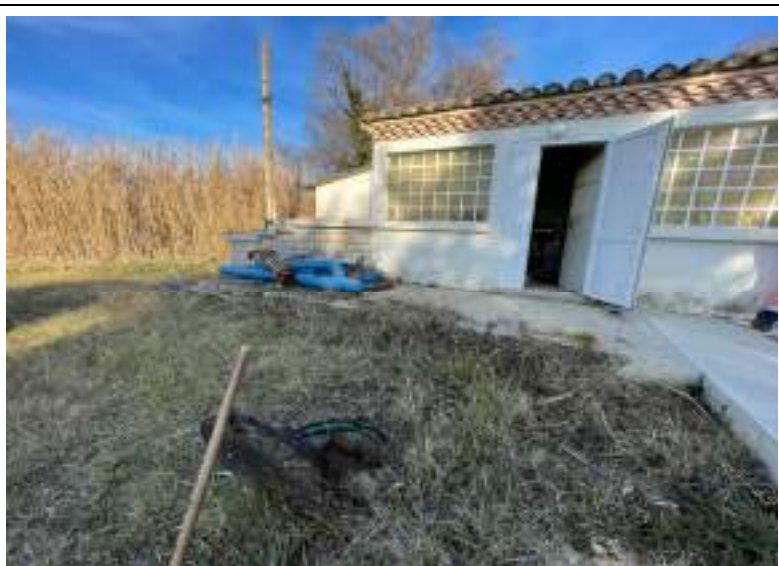
Vue extérieure de la station
