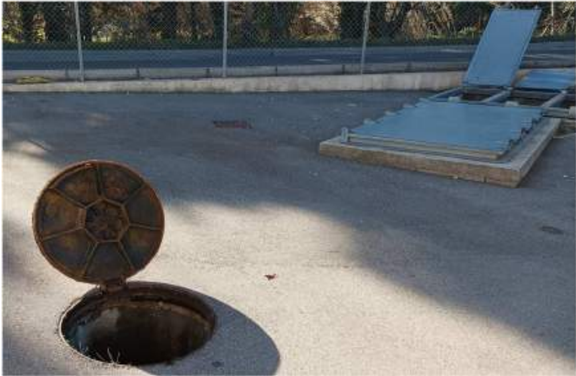
Regards Acier Profondeur = 1,75 m Conduite de départ de distribution
