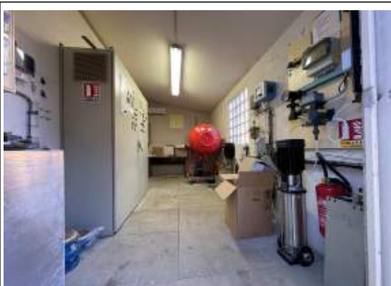
Intérieur du bâtiment d'exploitation
