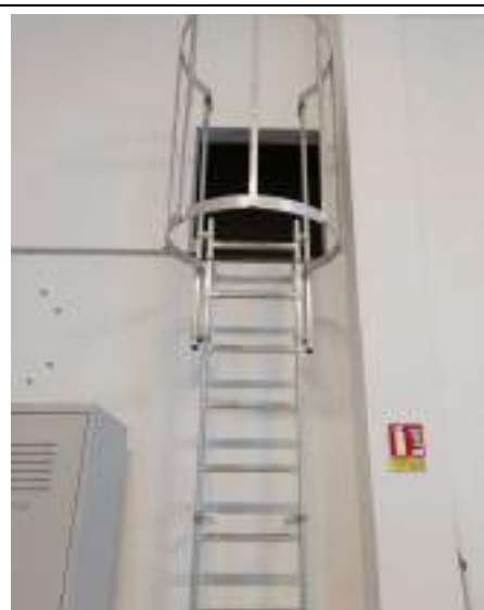
Accès à la cuve Sud
