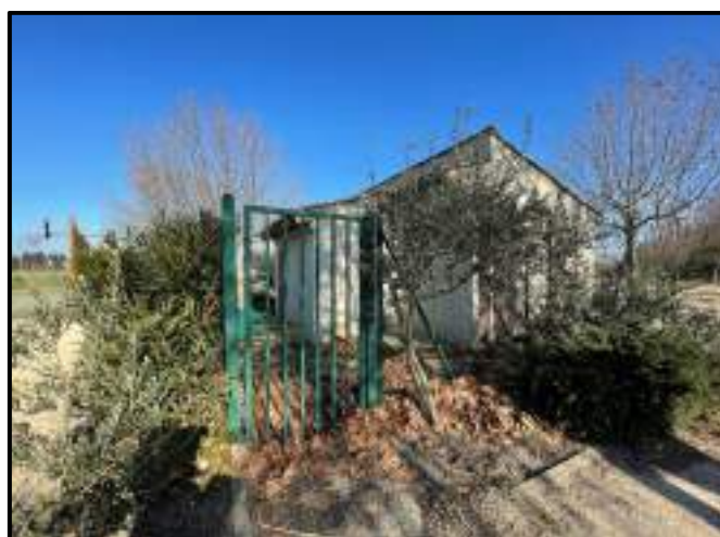
Figure 20 : Vue extérieure de la station de pompage du forage Mas-Blanc La Rode de la commune de Mas-Blanc-des-Alpilles
