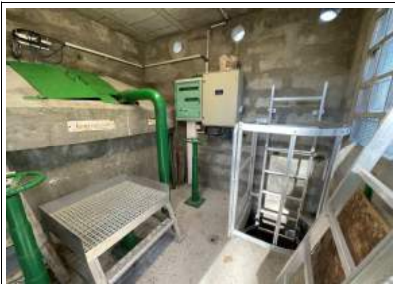
Accès cuve (Niveau 0)
