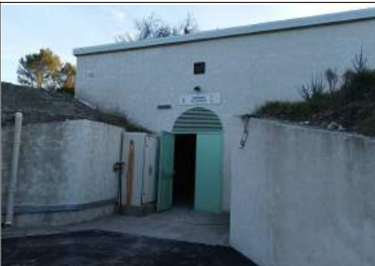
Vue extérieure du réservoir - entrée
