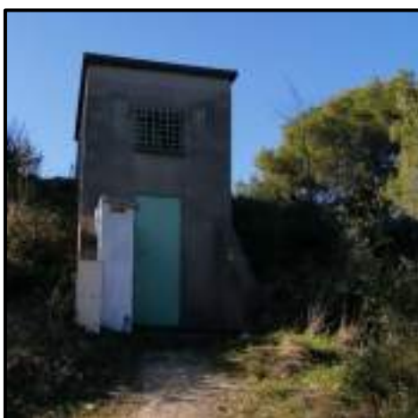
Figure 41 : Vue extérieure du réservoir de Saint-Etienne-du-Grès
