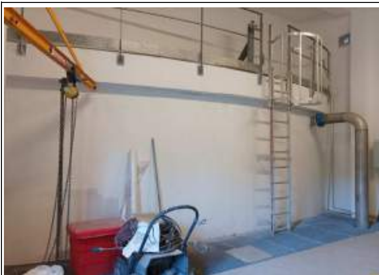
Accès à la cuve Nord
