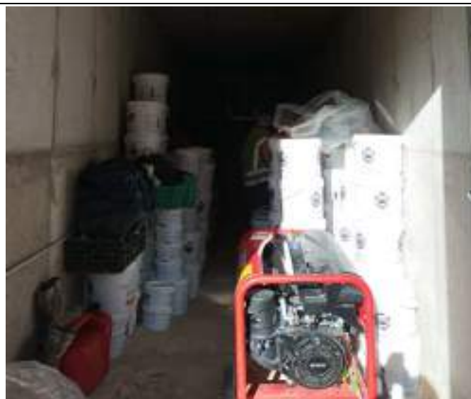
Accès à la chambre de vannes
