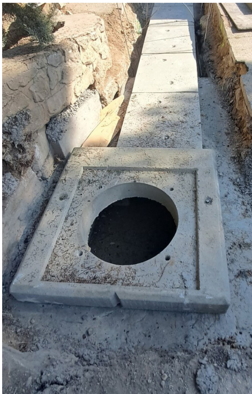
Travaux sur le réseau pluvial 2023
