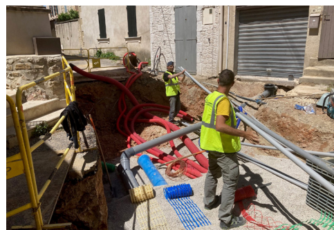
Travaux dans le centre ancien, à Aureille
