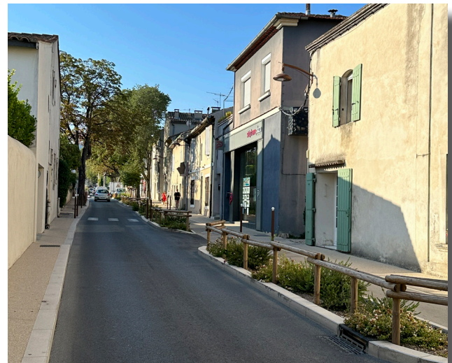
L'avenue Durand Maillane après les travaux
