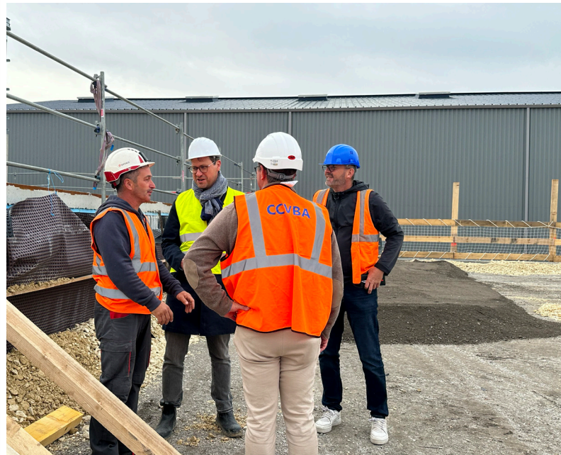
Réunion hebdomadaire de chantier
