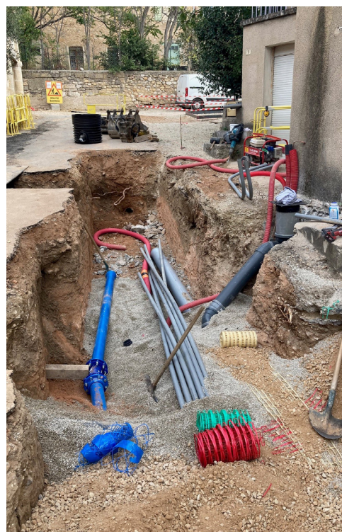
Travaux dans le centre ancien, à Aureille
