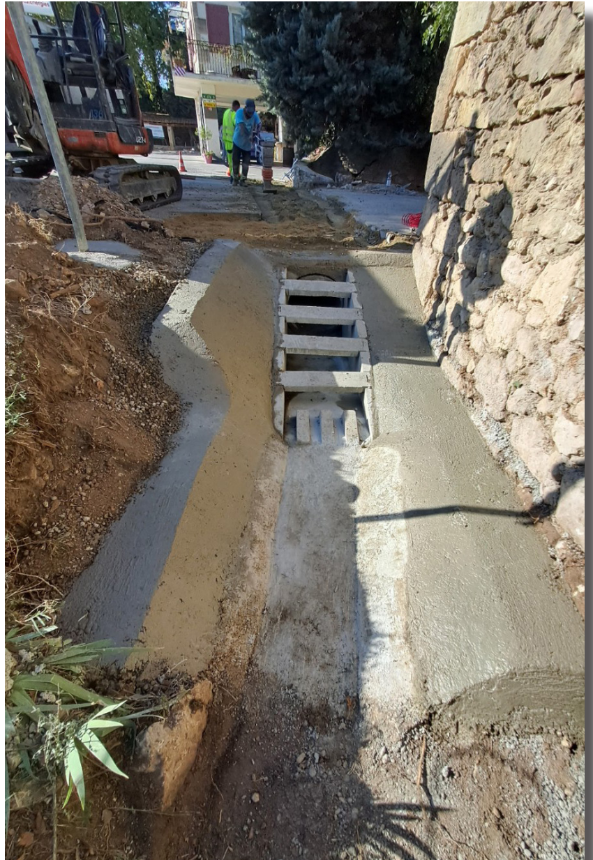
Avenue de la Vallée des Baux, au Paradou
