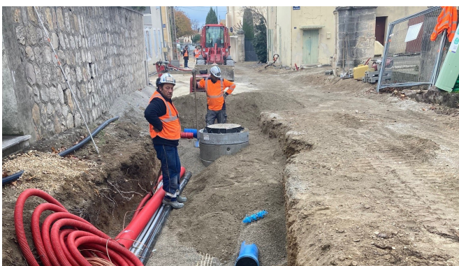
L'avenue Durand Maillane pendant les travaux
