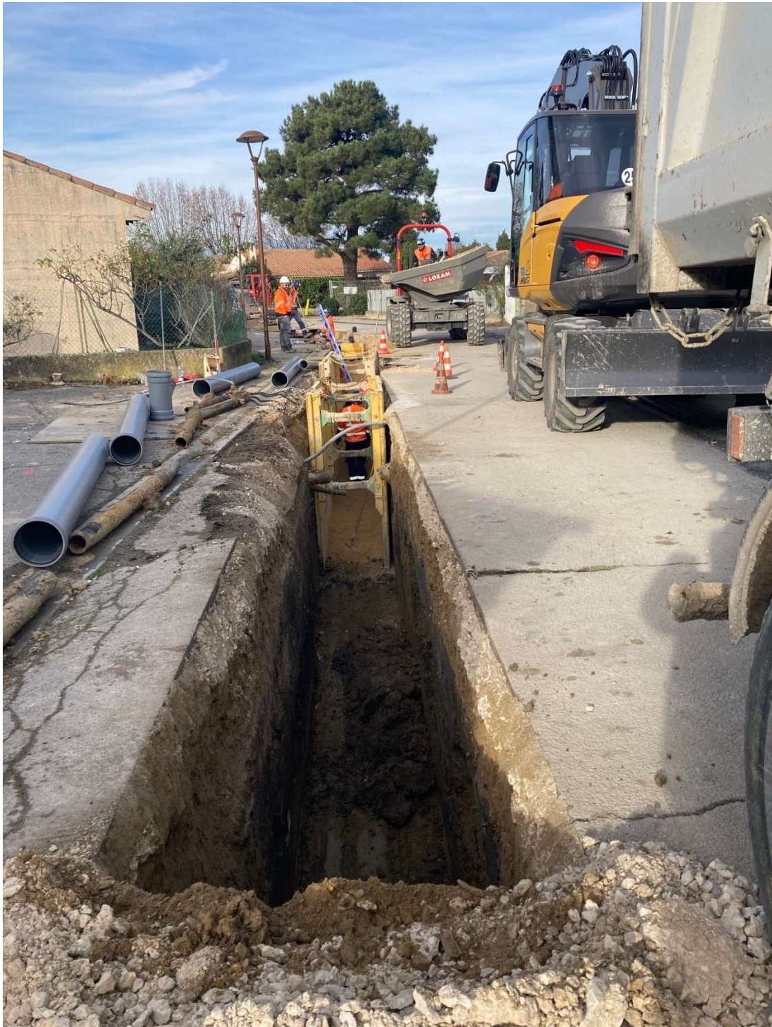
Lotissement Blanchin – Saint Rémy de Provence
