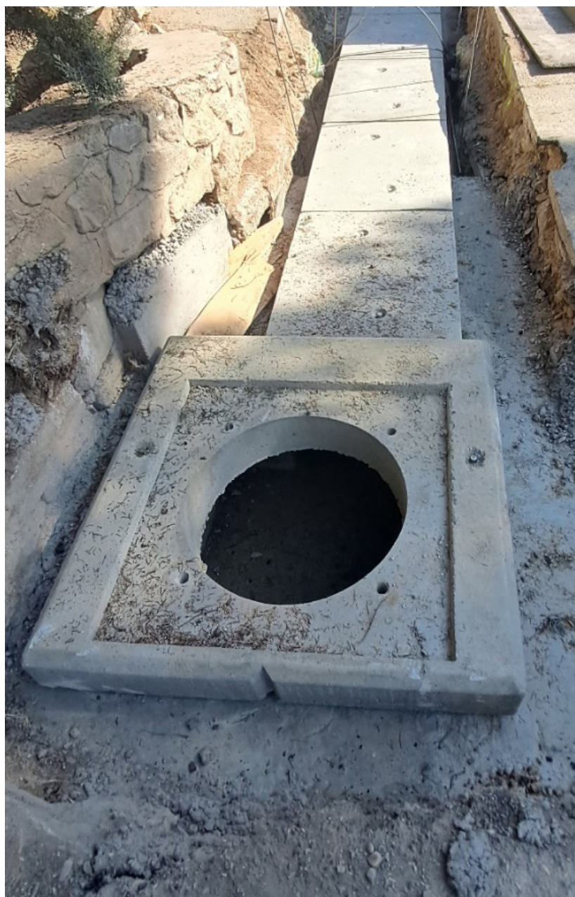
Travaux sur le réseau pluvial 2023
