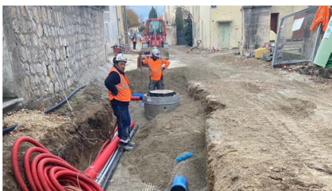
L'avenue Durand Maillane pendant les travaux
