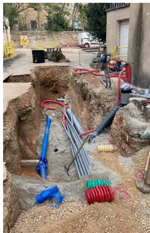
Travaux dans le centre ancien, à Aureille
