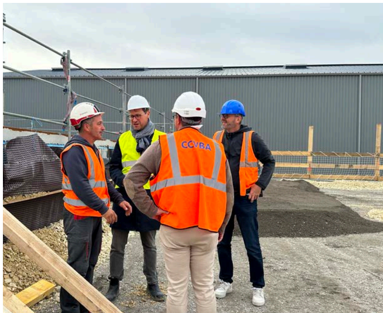
Réunion hebdomadaire de chantier
