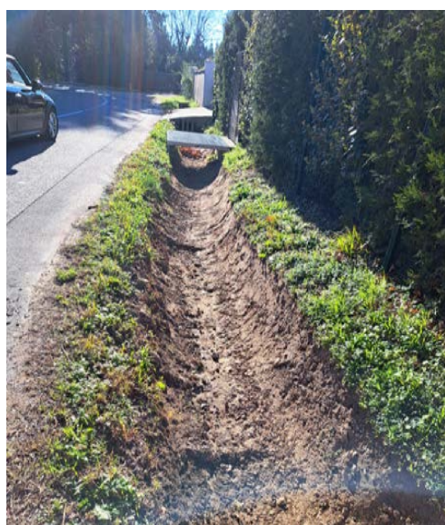
Curage fossé Chemin St Eloi à Maussane-les-Alpilles
