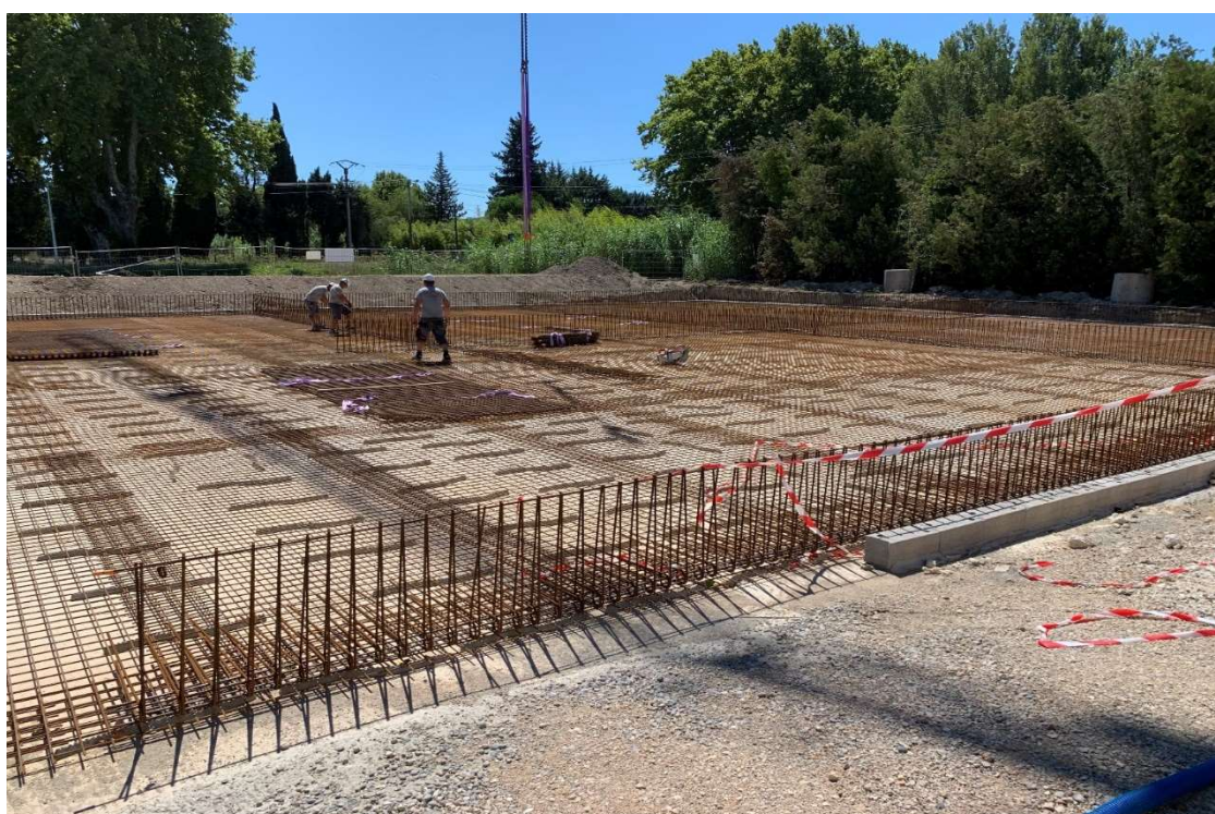
Construction lits plantés de roseaux – STEP Eygalières
