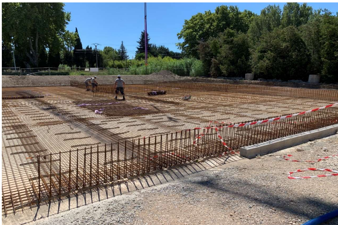
Construction lits plantés de roseaux – STEP Eygalières
