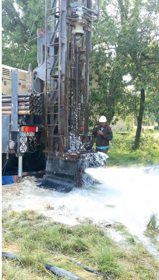
À Fontvieille des travaux de renforcement de la ressource en eau potable de la station de pompage de la Barjolle et des rénovations d'éléments de la station ont été conduits pour un montant de 352.749 € HT.
