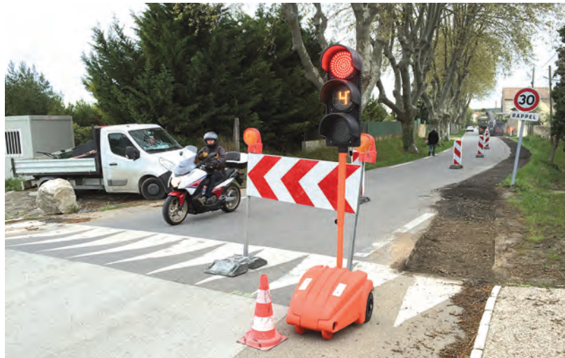
Fontvieille. Reprise de réseau d'assainissement avenue de Montmajour avec la pose d'une nouvelle canalisation d'un diamètre de 200 mm.
