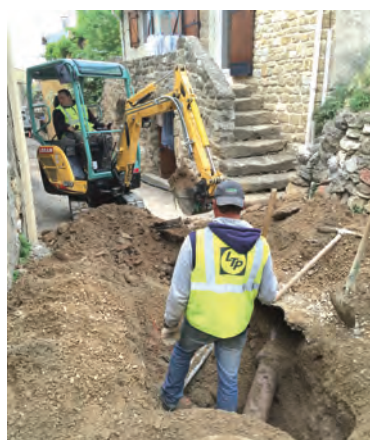
Aureille. Remplacement du réseau d'assainissement rue Marmittone et reprise de réseau d'assainissement rue des Pontins.
