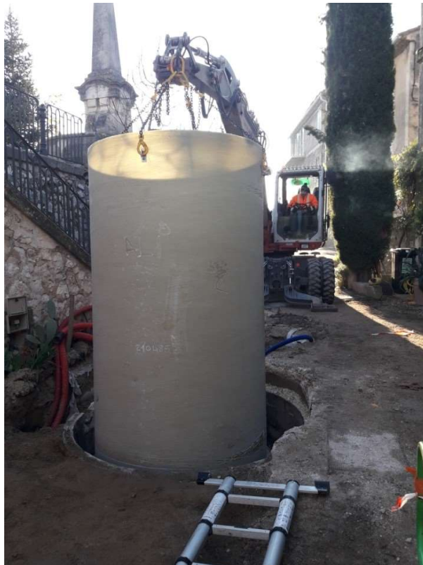
Pose poste de refoulement Impasse Vieille Fontaine – Eygalières
