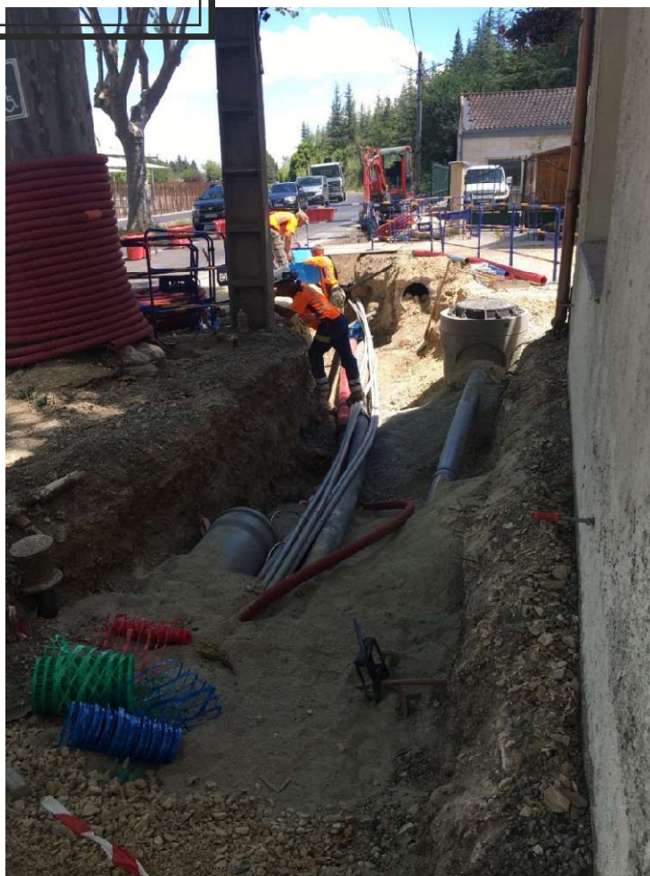
Renouvellement réseau assainissement Place de la Mairie – RD99 – Saint Etienne du Grès
